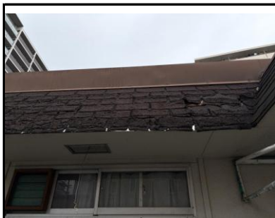
試料No.20：アスファルトシングル葺
