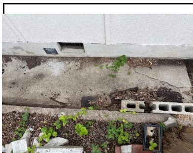
試料No.31：モルタル2
