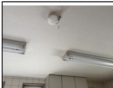
試料No.16：石膏ボード下地クロス6
