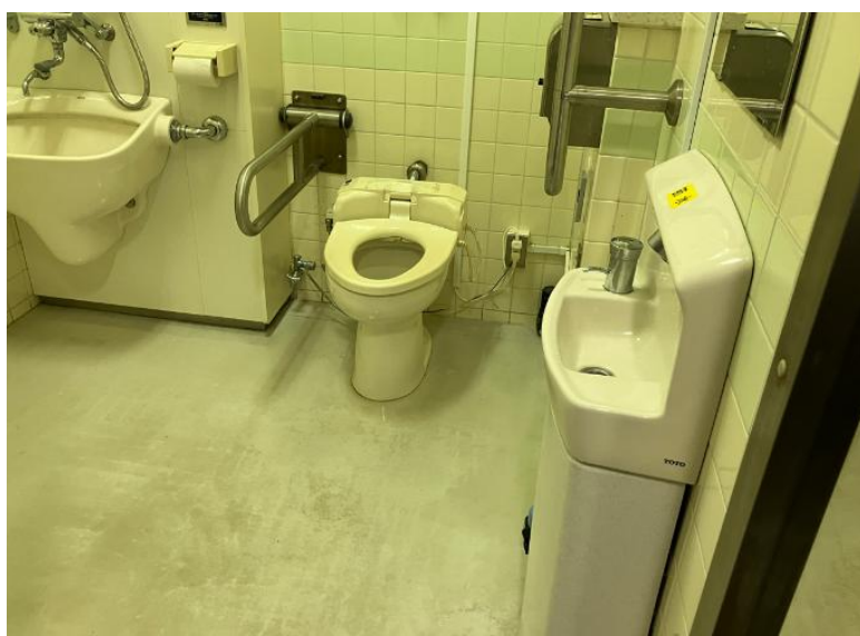
現況トイレ写真
