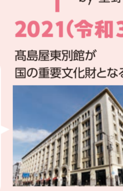
写真提供:高島屋東別館
