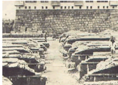
大阪城内配水池隔壁の工事
