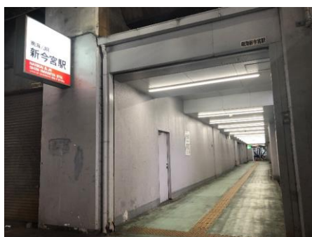
南北通路の様子
