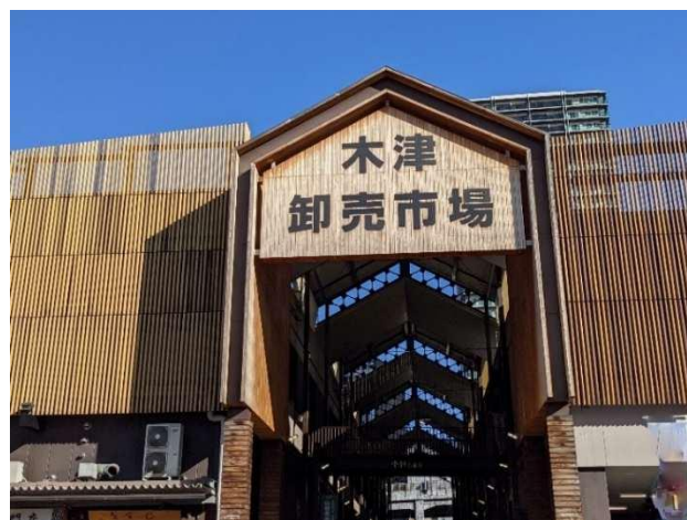
大阪木津卸売市場 (写真提供:大阪木津卸売市場)
