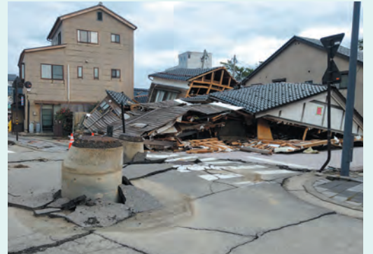
家屋の倒壊と液状化で隆起したマンホール
