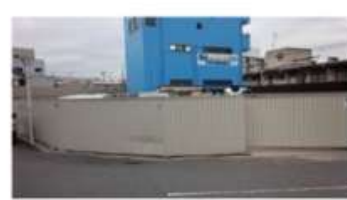
売却済み市有地の現状(20131209) ○777 貨物駐車場及び物置(隣接地主への売却)
