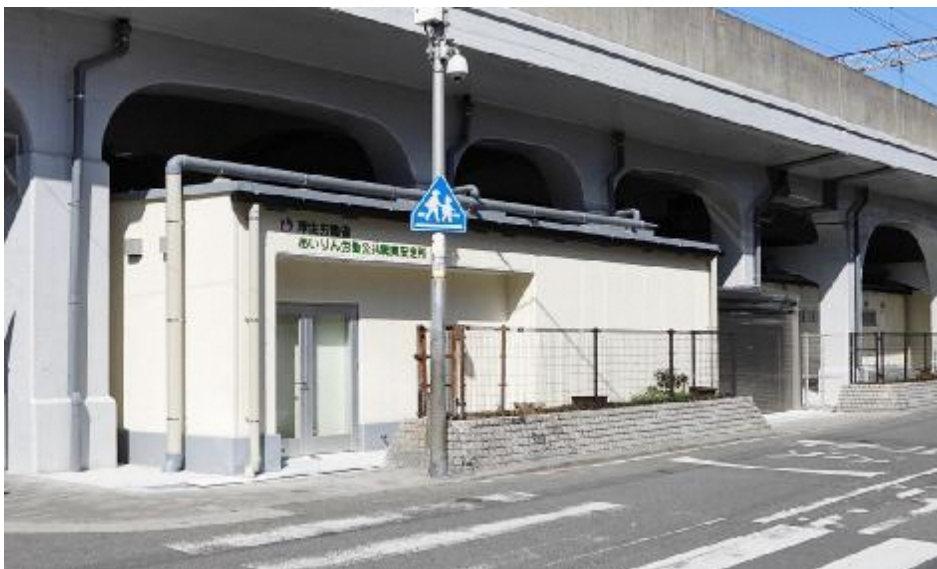
《執務室棟 南東側 外観》
