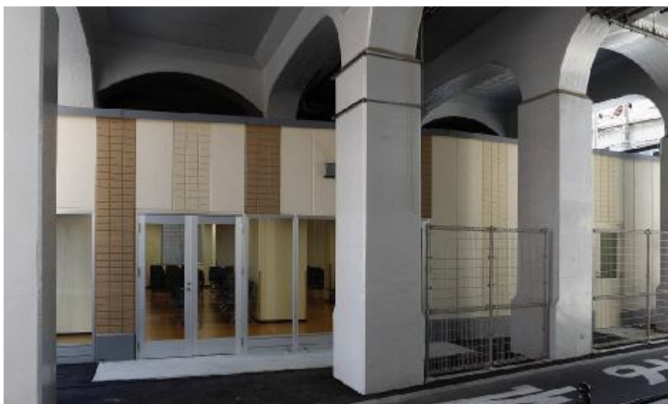
《待合室棟 北側 外観》
