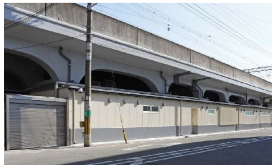
《執務室棟 北西側 外観》
