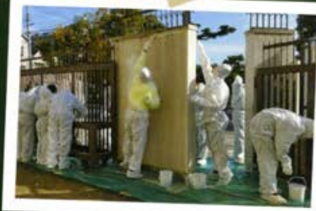
▲校舎・門扉のペンキ塗り
