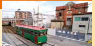
右の赤レンガの建物は、明治44年築の玉出変電所
