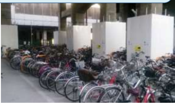
南海新今宮駅南高架下自転車置場
