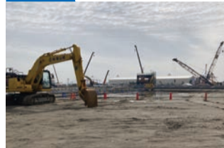
建築工事の様子
