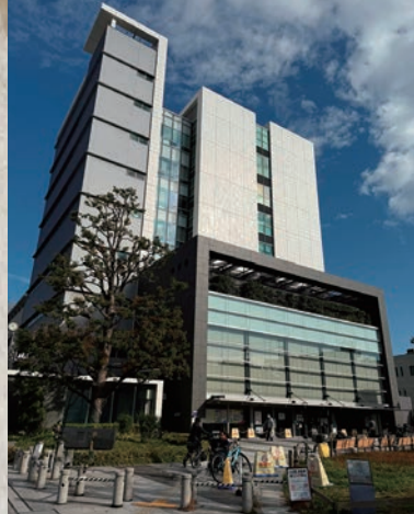
西成区役所新庁舎
