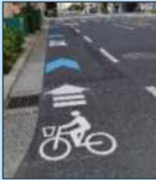
▲幹線道路における矢羽根型路面表示等の設置状況(上町筋)
