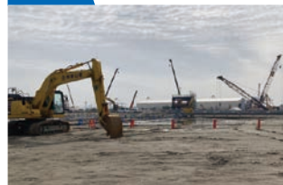
建築工事の様子
