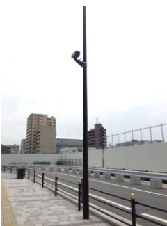
□設置状況(固定型)
