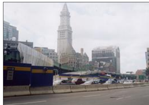
図-7 高架高速道路 撤去工事中 (2004 年)
