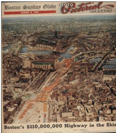
図-3 高架高速道路 建設中 (1954 年)
