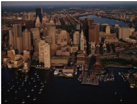
図-4 高架高速道路 供用中
