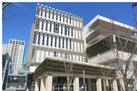
エネルギー棟 電力融通装置、太陽光発電や蓄電池等 (ショップ&オフィス棟の西側)
