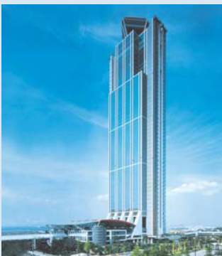
● 大阪府咲洲庁舎
