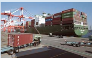
● 夢洲コンテナターミナル
