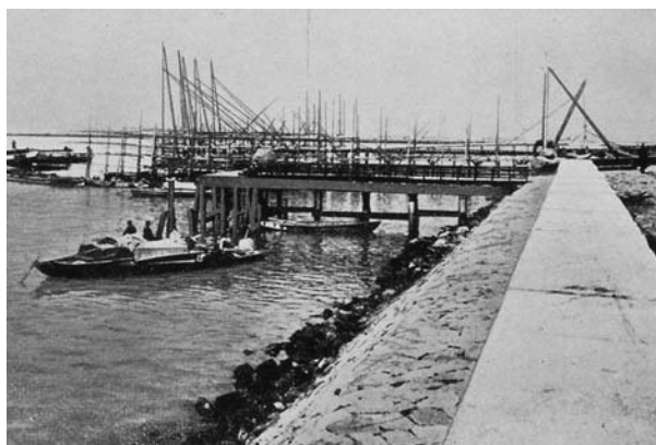
築港大棧橋の工事（今の中央突堤） 大型の船が横付けできる大棧橋をつくり、沖に10 kmの防波堤を築く大工事でした。
