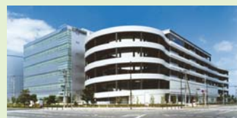
舞洲の物流施設
