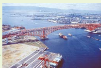
完成した港大橋
