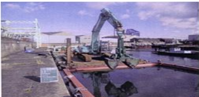
浚渫船による汚染底質の除去
