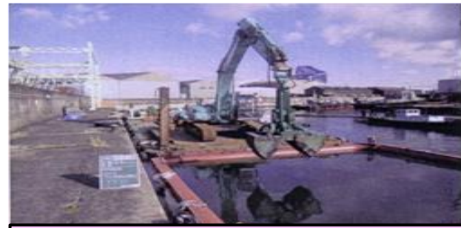
浚渫船による汚染底質の除去
