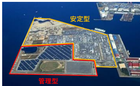
泉大津沖埋立処分場
