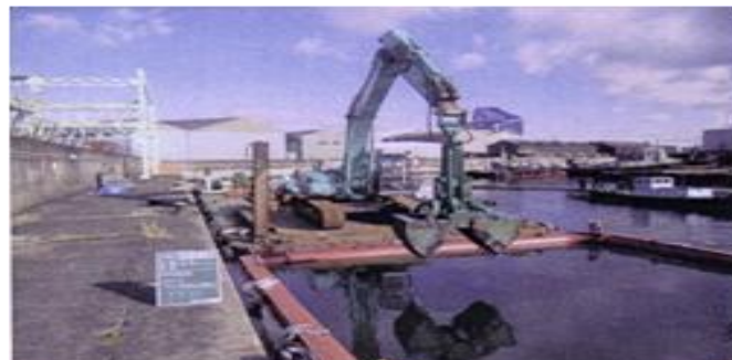
浚渫船による汚染底質の除去
