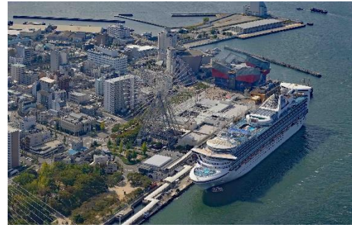
図 2-8 大阪港天保山岸壁周辺
