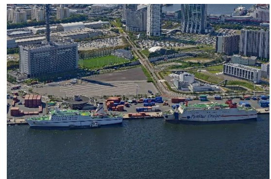
図 2-15 大阪港国際フェリーターミナル
