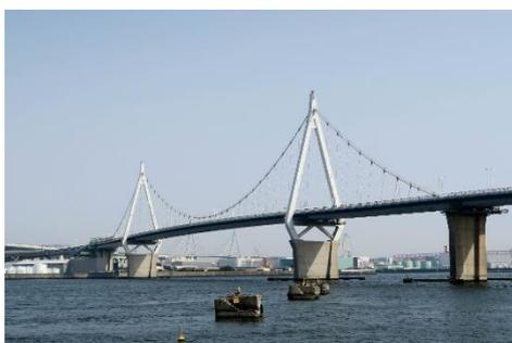
此花大橋は、此花区北港(既成市街地)と、舞州(まいしま)(人工島)を結ぶ橋として平成 2 年(1990 年)に完成した、全長 1.7km の長大橋です。主橋部は、世界でも珍しいモノケーブル自碇式吊橋(主径間 300m)と呼ばれる形式で、1 本のメインケーブルによって橋桁を吊り下げている構造となっています。此花大橋の名前は、此花区のシンボルとなる橋として、市民に親しまれるように命名された橋で、橋上からの眺望はすばらしく、大阪港を代表する橋の一つです。
