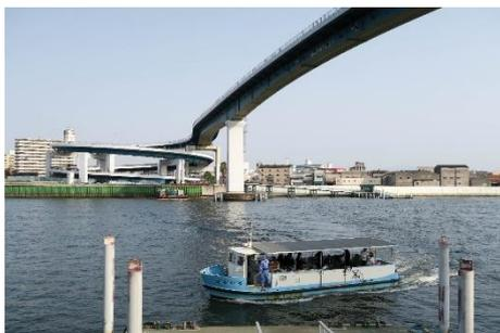
千本松渡船は大正区南恩加島(みなみおかじま)1 丁目と西成区南津守 5 丁目を結んでいます(岸壁間 230m)。千本松の渡しが設けられた年代ははっきりしませんが、大正時代の中頃に初めて設けられたものと思われます。昭和 48 年(1973 年)には、この岸壁間に千本松大橋が完成し、地元では「めがね橋」の愛称で呼ばれています。橋下を大型船舶が航行できるよう桁下高を 33m 確保し、両端部の 2 階式ラセン状ランプウェイを含めた橋長は 1,228m におよびます。
