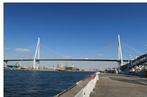
【写真 04】天保山大橋
