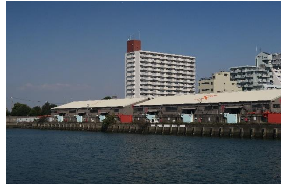
図 3-6 安治川基部岸壁上屋
