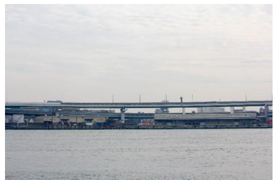
図 3-10 安治川第1号岸壁上屋(未塗装替)
