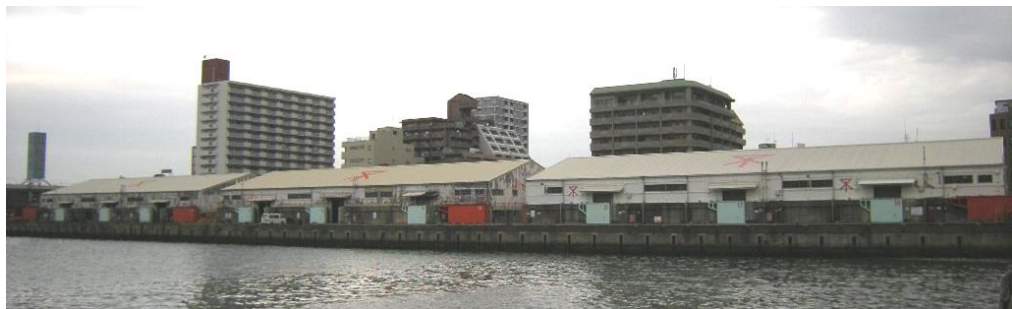
図 3-7 安治川第2号岸壁上屋(未塗装替)
