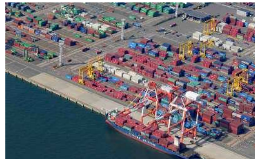
図 2-11 夢洲コンテナターミナル
