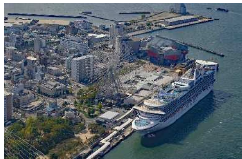
図 2-8 大阪港天保山岸壁周辺
