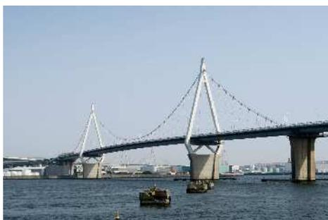
此花大橋は、此花区北港(既成市街地)と、舞州(まいしま)(人工島)を結ぶ橋として平成 2 年 (1990 年) に完成した、全長 1.7km の長大橋です。主橋部は、世界でも珍しいモノケーブル自旋式吊橋(主径間 300m)と呼ばれる形式で、1本のメインケーブルによって橋桁を吊り下げている構造となっています。此花大橋の名前は、此花区のシンボルとなる橋として、市民に親しまれるように命名された橋で、橋上からの眺望はすばらしく、大阪港を代表する橋の一つです。
