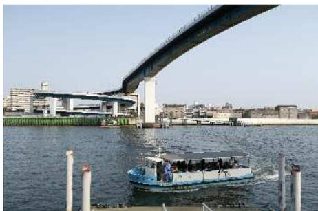
千本松渡船は大正区南恩加島(みなみおかじま)1 丁目と西成区南津守 5 丁目を結んでいます(岸壁間 230m)。千本松の渡しが設けられた年代ははっきりしませんが、大正時代の中頃に初めて設けられたものと思われます。昭和 48 年(1973 年)には、この岸壁間に千本松大橋が完成し、地元では「めがね橋」の愛称で呼ばれています。橋下を大型船舶が航行できるよう桁下高を 33m 確保し、両端部の 2 階式ラセン状ランブウェーを含めた橋長は 1,228m におよびます。
