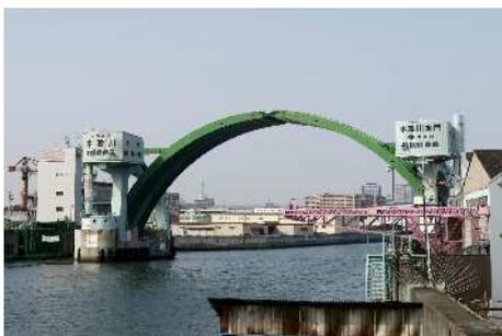
造船所などがならぶ木津川にあるアーチ型水門であり、台風などで押し寄せてくる大阪湾からの高潮をせき止めることを目的に、昭和 45 年(1970 年)11 月に整備されました。アーチ型ゲートの主水門とスイング式ゲートの副水門からなっており、主水門の径間は 57m、副水門の径間は 15m、ともに緑色で彩られ象徴的な景観を呈しています。
