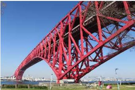
昭和 49 年(1974年)に完成した最大支間長 510m のダブルデッキ形式のゲルバートラス橋で、阪神高速道路に架けられた橋の中で最も長い支間長を持ち、トラス橋としては世界第 3 位の規模を誇っています。また、橋下を 4 万トン級の大型コンテナ船が航行できるよう、海面から桁下までは 50m 以上の空間が確保されています。そのスケールや色彩、重量感から、大阪港のランドマークになっています。
