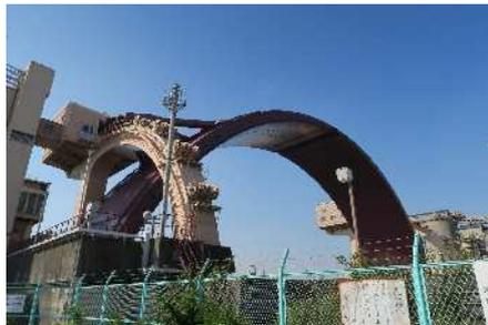
大阪ではジェーン台風や第 2 室戸台風など高潮による大きな被害を受けてきたことから、その対策として、昭和 45 年(1970年)に建設された水門です。耐震、耐風の安全性や、船舶航行時の必要上部空間を確保できることからアーチ型水門(幅 57m)が採用されました。
