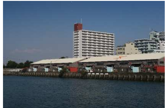
図 3-6 安治川基部岸壁上屋
