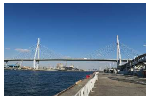
【写真 04】天保山大橋
