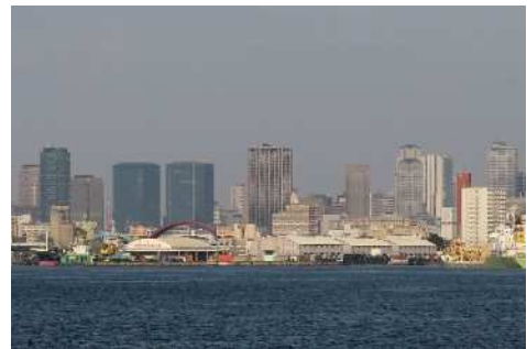
【写真 12】安治川水門と安治川突堤
