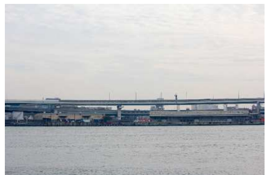
図 3-10 安治川第1号岸壁上屋(未塗装替)
