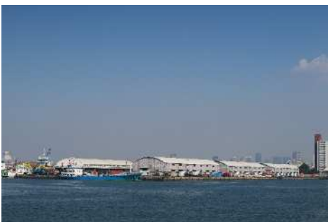
【写真 13】安治川突堤のアーチ屋根上屋
