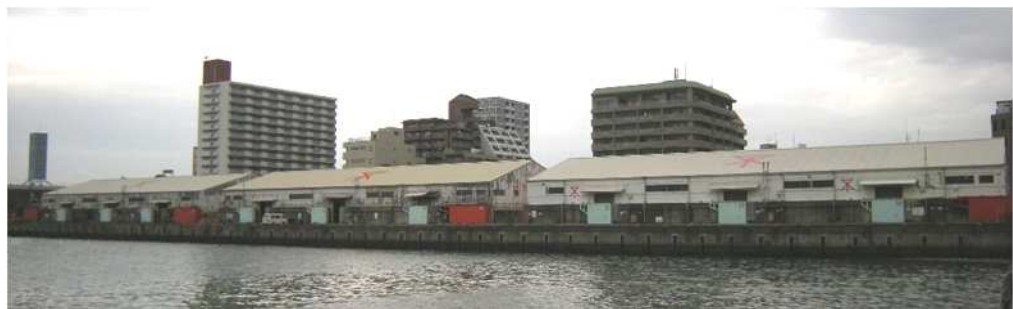
図 3-7 安治川第2号岸壁上屋(未塗装替)
