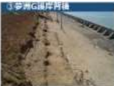
③ 夢洲G岸壁
