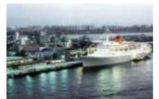
昭和63年改修まもない天保山岸壁
