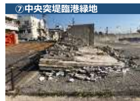
⑦中央突堤臨港緑地
