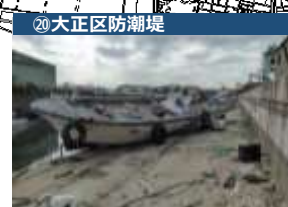
⑳大正区防潮堤
