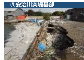
⑨安治川突堤基部
