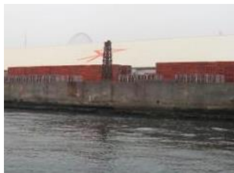
防潮堤(港区埠頭地区)
