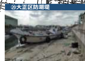
⑳大正区防潮堤
