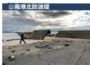
(防波堤破損)
