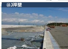
(ソーラースタンド破損)
