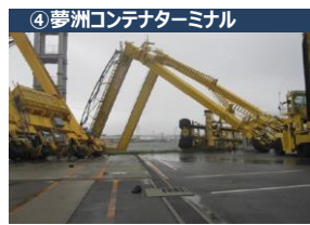
(トランスレーン破損)
