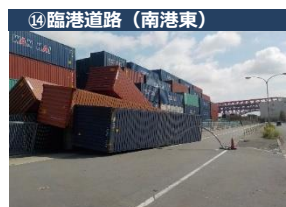
(コンテナ荷崩れによる照明灯破損)
