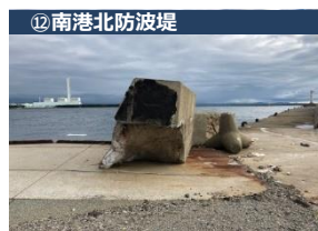
(防波堤破損)
