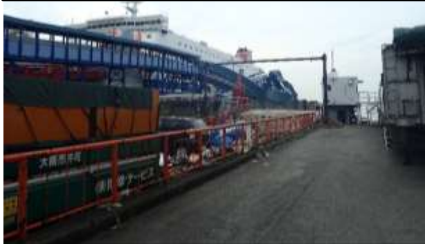
⑥ボーディングブリッジ倒壊状況（全景）
