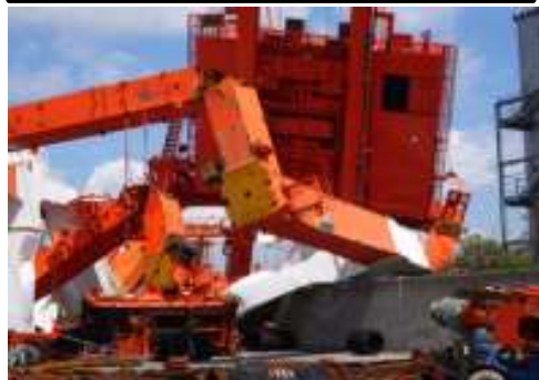
⑨クレーン倒壊（防潮堤損壊）
