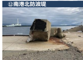
(防波堤破損)
