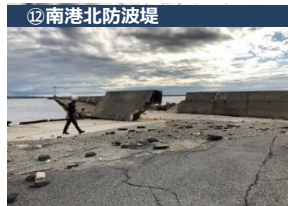
(防波堤破損)
