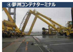
(トランスレーン破損)
