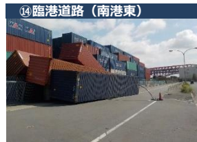
(コンテナ荷崩れによる照明灯破損)
