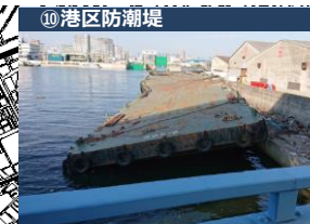
(防潮堤前面への台船乗り揚げ)
