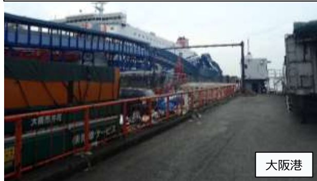
ボーディングブリッジ倒壊状況（全景）
