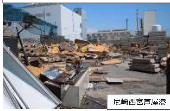
公共ふ頭施設被害（資材置場）
