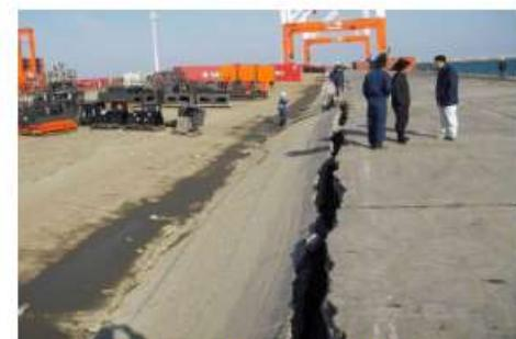
非耐震強化岸壁背後の陥没
