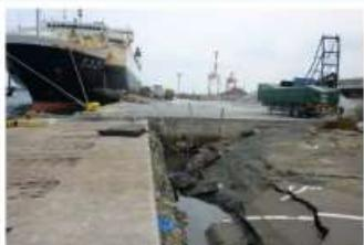
非耐震強化岸壁背後の陥没
