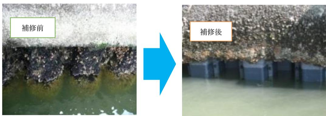
計画的な修繕方法の例（土留鋼矢板の腐食の補修）
