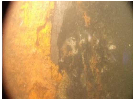
鋼部材：腐食による孔食：水中
