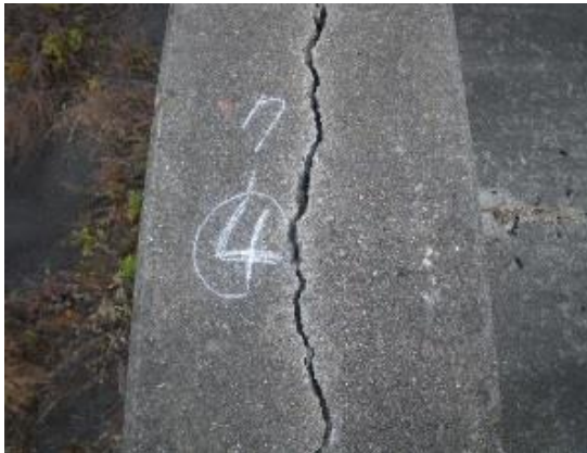
コンクリート部材：ひび割れ：陸上
