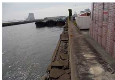
防潮堤:水たたき部損傷 (港区海岸通り)
