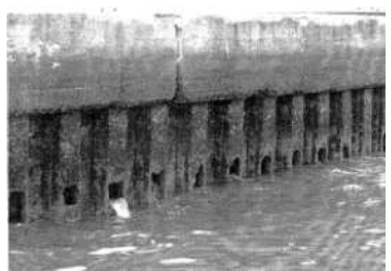
防潮堤:土留め矢板腐食開孔 (木津川運河南岸)
