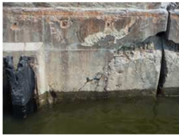
岸壁上部工前面ひび割れ (常吉岸壁)
