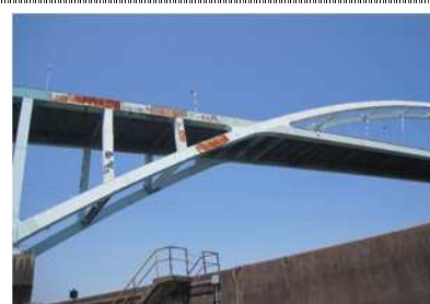
橋梁塗装劣化(塩害) (新木津川大橋)
