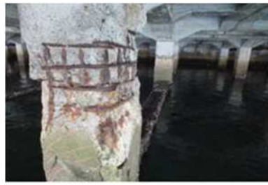
栈橋脚柱部鉄筋露出 (大正 10 号岸壁)
