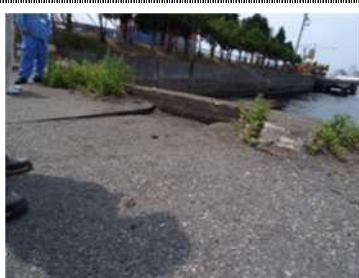
目地部吸出し陥没 (南港北護岸)
