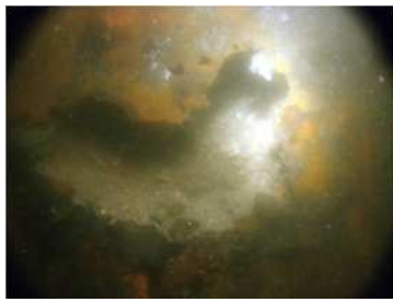
鋼管杭腐食開孔 (南港 1・2 区東物揚場)
