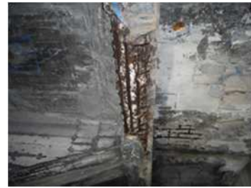
栈橋下面梁部鉄筋露出 (安治川 2 号岸壁)
