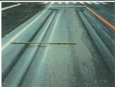
臨港道路 舗装ひびわれ (50%)
