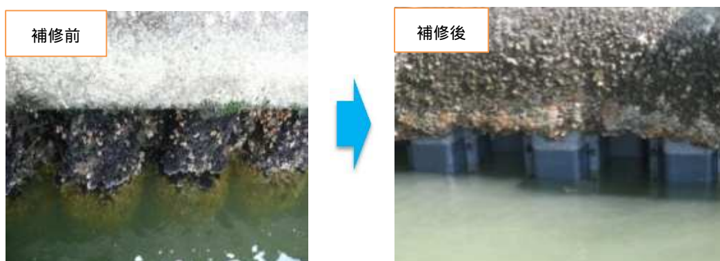
写真-4.2 土留鋼製矢板の腐食の補修（被覆防食）
