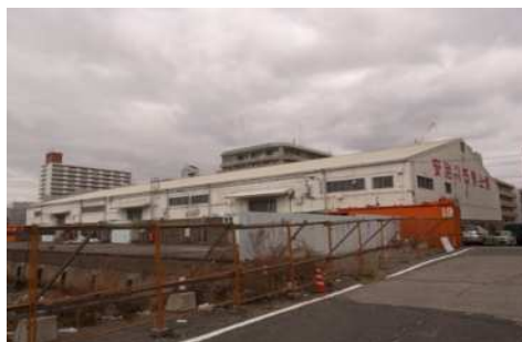
写真-4.3 立入禁止措置
