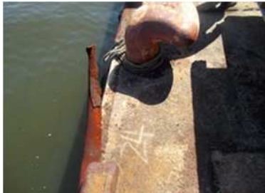
コーナー保護材損傷 (南港 G 岸壁)
