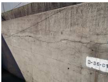
防潮堤:縦壁ひび割れ (木津川右岸)
