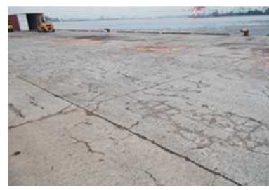
エプロン部ひび割れ (港区 3 号岸壁)
