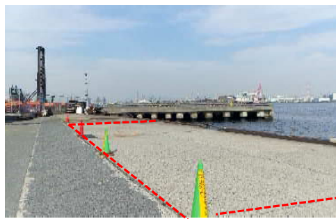
写真-4.4 一部利用制限措置
