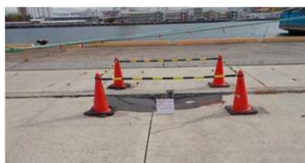
写真-4.5 一部利用制限措置
