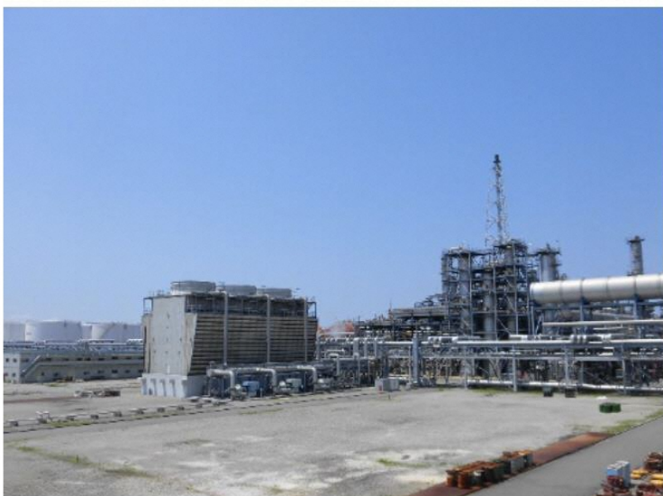
建設予定地写真
