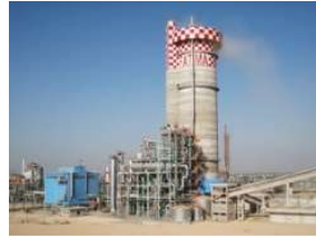
肥料プラント (水素大量製造)
